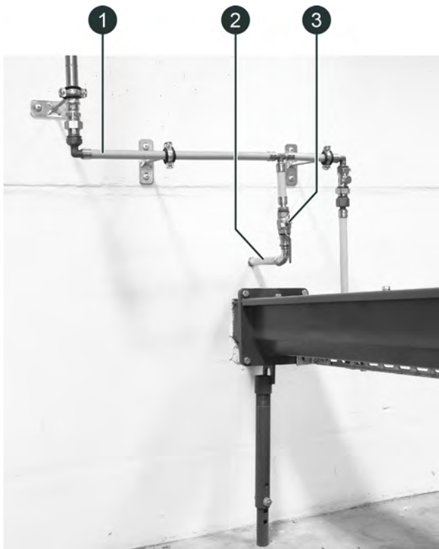
Fig. 8-3: Dispositif d'extinction à déclenchement manuel
