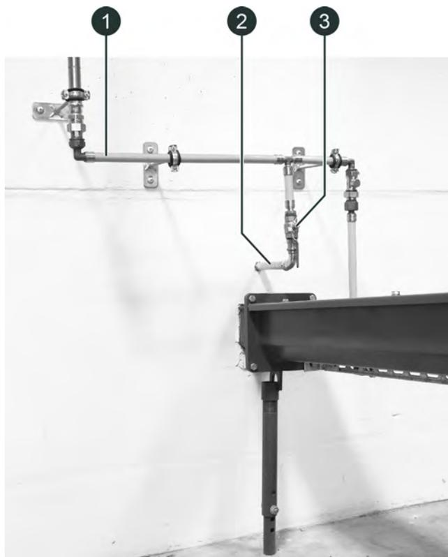
Fig. 7-12: Dispositif d'extinction à déclenchement manuel
