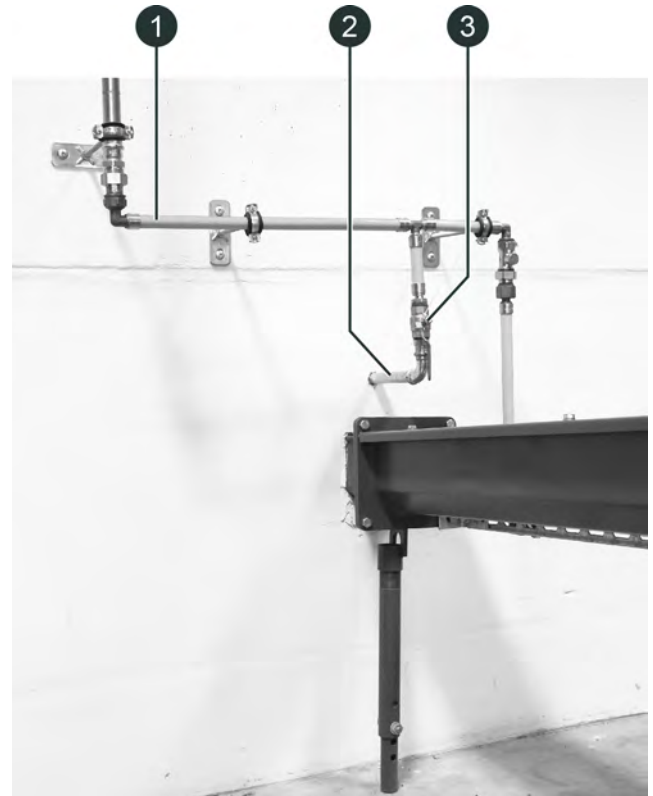
Fig. 7-12: Dispositif d'extinction à déclenchement manuel
